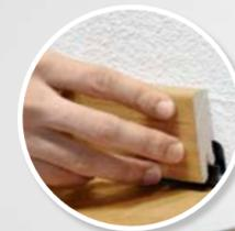
Beispiel: Sockelleiste mit CLIPSTAR Befestigung
